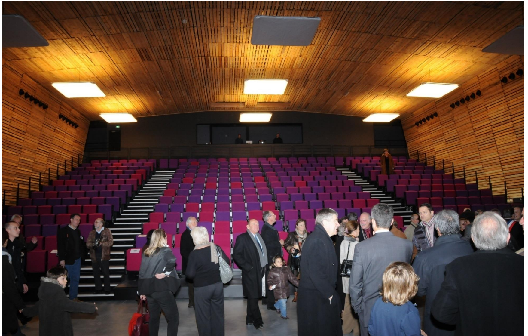
Salle de spectacle à Mazan (Vaucluse) – 2012 – Parement acoustique intérieur en pin à crochet Maître d'ouvrage : Commune de Mazan – Architectes : François DEFRAIN – Olivier SOUQUET
