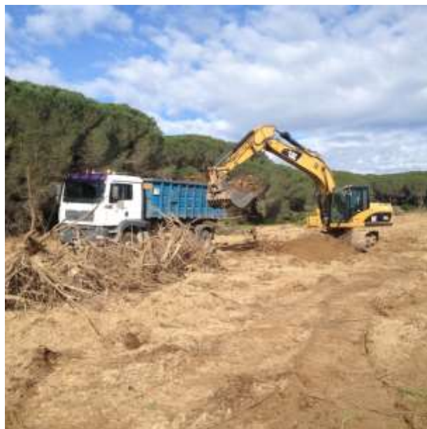
Reprise des souches par la pelle à godet "squelette"
