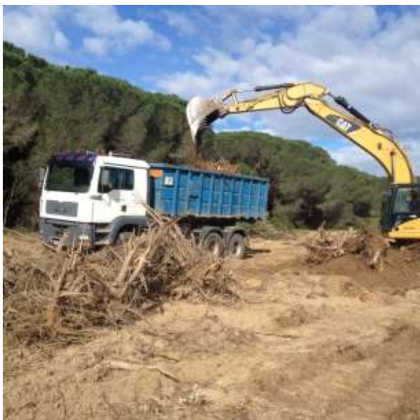
Reprise des souches par la pelle à godet "squelette"
